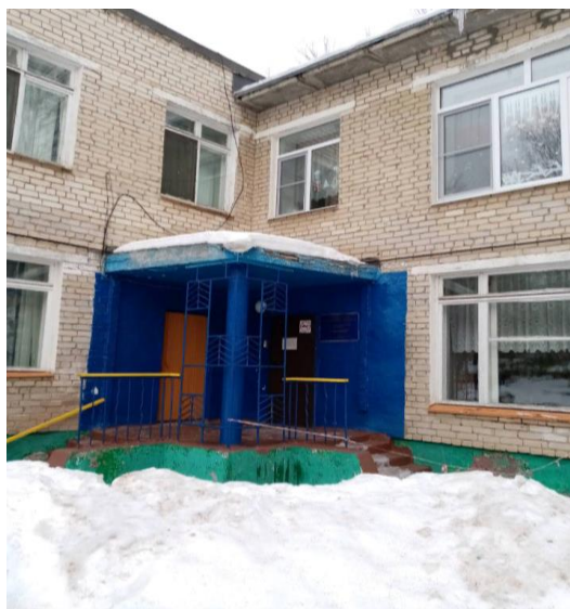
Фото № 5 Лестница наружная
