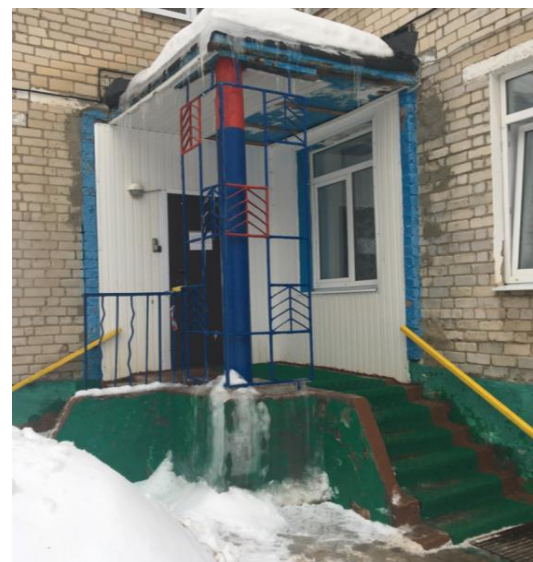
Фото № 6 Лестница наружная
