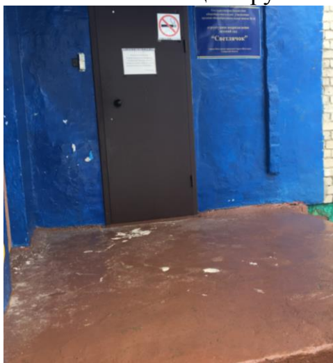
Фото № 7 Входная площадка и дверь (входная)
