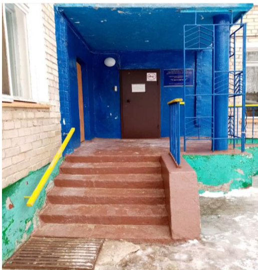
Фото № 5 Лестница (наружная) с другой стороны здания
