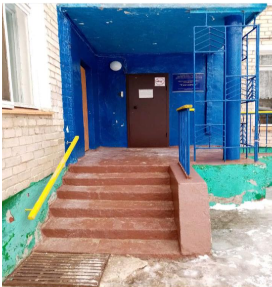
Фото № 4 Лестница наружная
