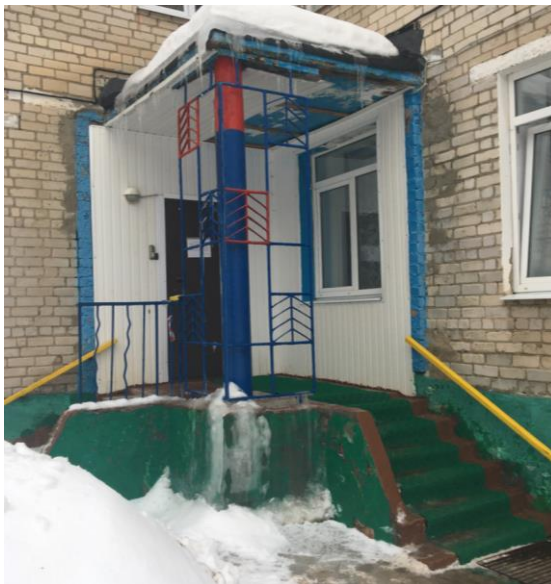
Фото № 4 Лестница (наружная) с одной стороны здания
