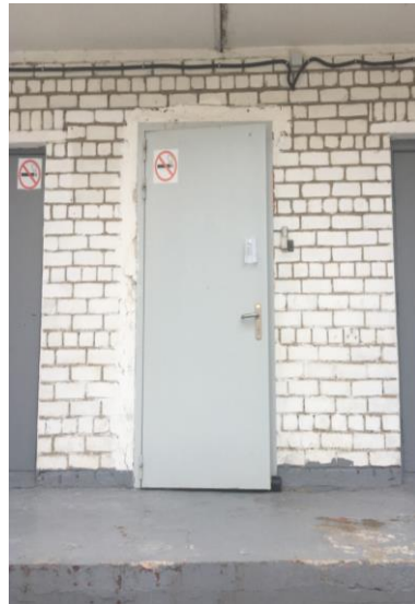
Фото № 7 Дверь (входная)
