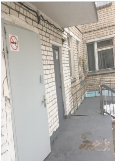
Фото № 6 Входная площадка
