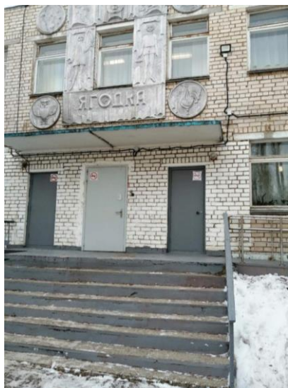
Фото № 4 Лестница (наружная)
