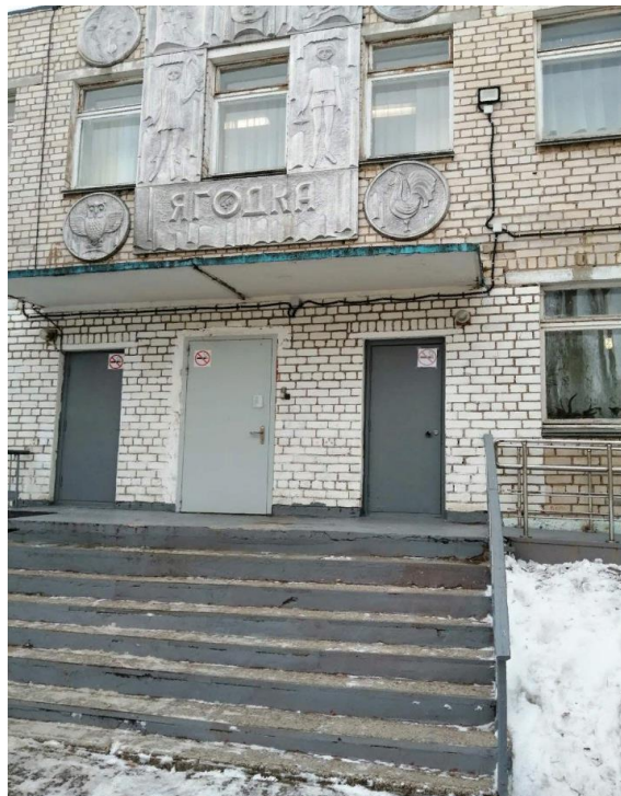
Фото № 4 Лестница наружная
